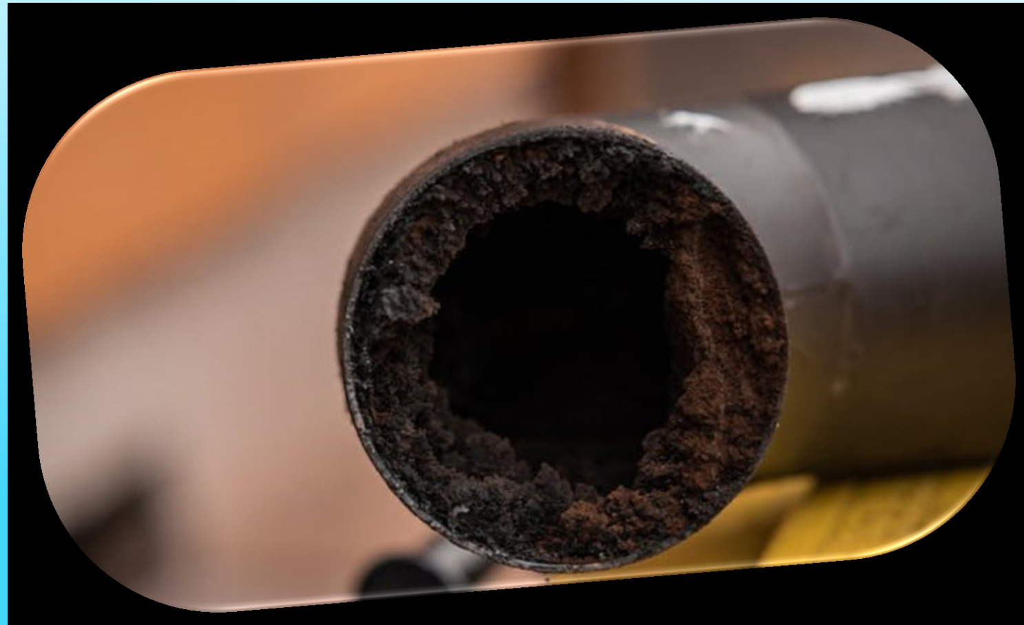
Zanesená spalínová cesta
