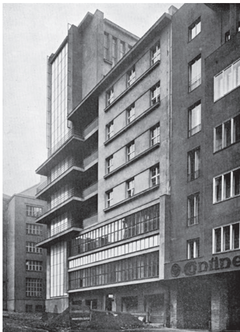
Stavba dne 31. prosince 1928, pohled z Blanické ulice, vpravo budova ředitelství firmy Continental, známého výrobce pneumatik
