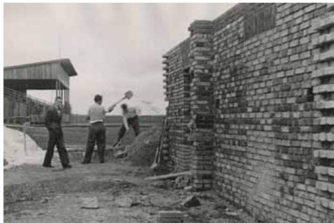
Stavba hasičských garáží u fotbalového hřiště
